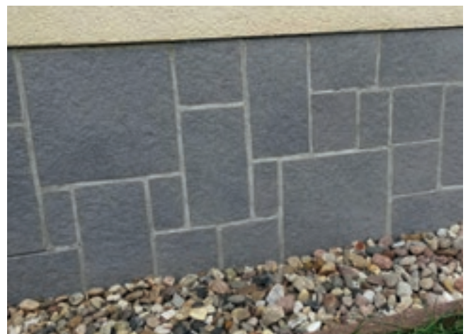
31 Abdichtung mit Steinzeugfliesen
